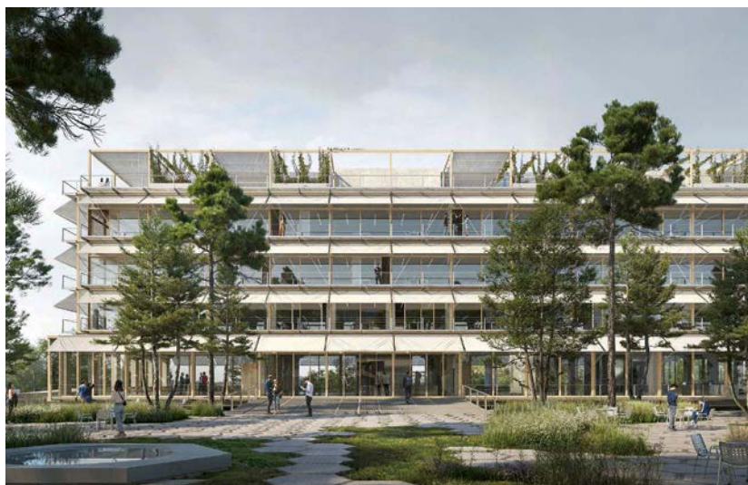
Der verglaste Baukörper «Equilibres» von ARGE Buchner Bründler Planer/Rapp Architekten ist durch umlaufende Terrassen und weit auskragende Ausstellmarkisen geprägt.
