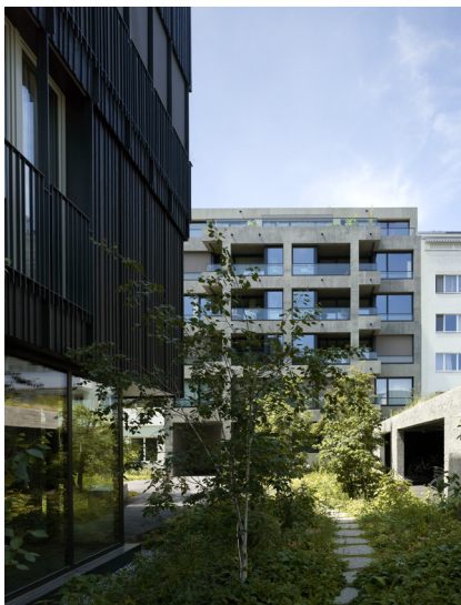
Blick am Hofhaus vorbei aufs Vorderhaus.
