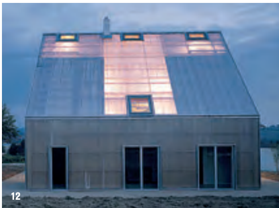
10-13 Luftkollektoren, Wohnhaus in Müllheim, Pfeifer Kuhn Architekten, Freiburg 2005 (Bilder: Architekten)
